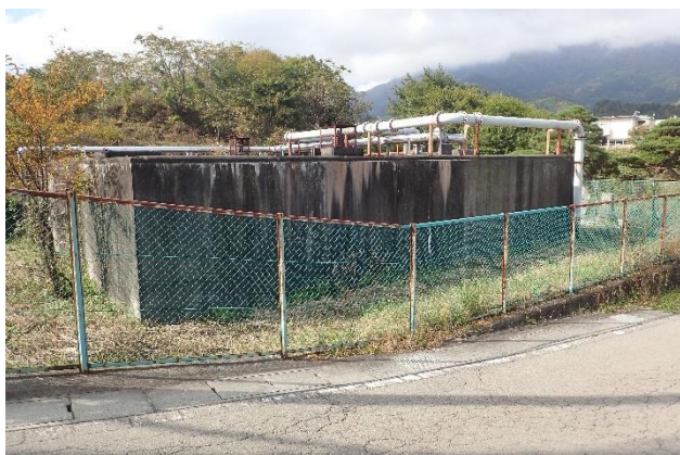
写真 8.1.8-13 西桂町高区配水池 コンクリート構造物・配管・舗装
